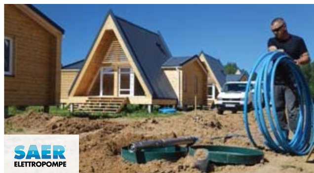
Поставка, монтаж и запуск артезианских насосов SAER в коттеджном поселке
