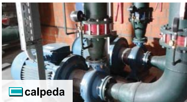
Поставка насосного оборудования Calpeda в логистический комплекс
