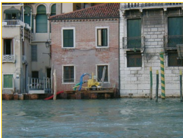
Restoration work at Venice Erhaltungsarbeiten in Venedig Реставрационно-консервационные работы в Венеции
