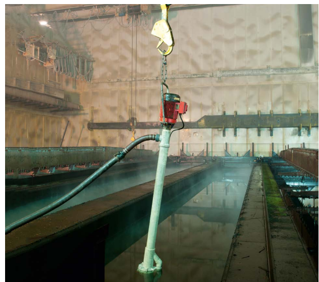
F 640 – Выкачивание разбавленной серной кислоты.
