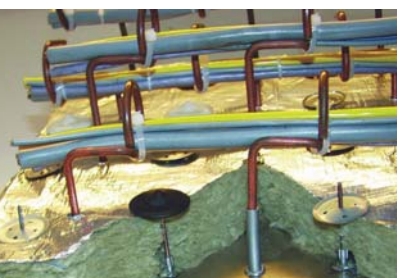
Крепление теплоизоляции и кабелей
