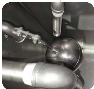
Бак жидкостный с контролем уровня
