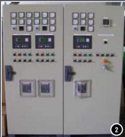
2. Панель синхронизации и параллельной работы нескольких электростанций.
