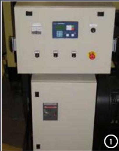
1. Панель параллельной работы смонтированная на электростанции
