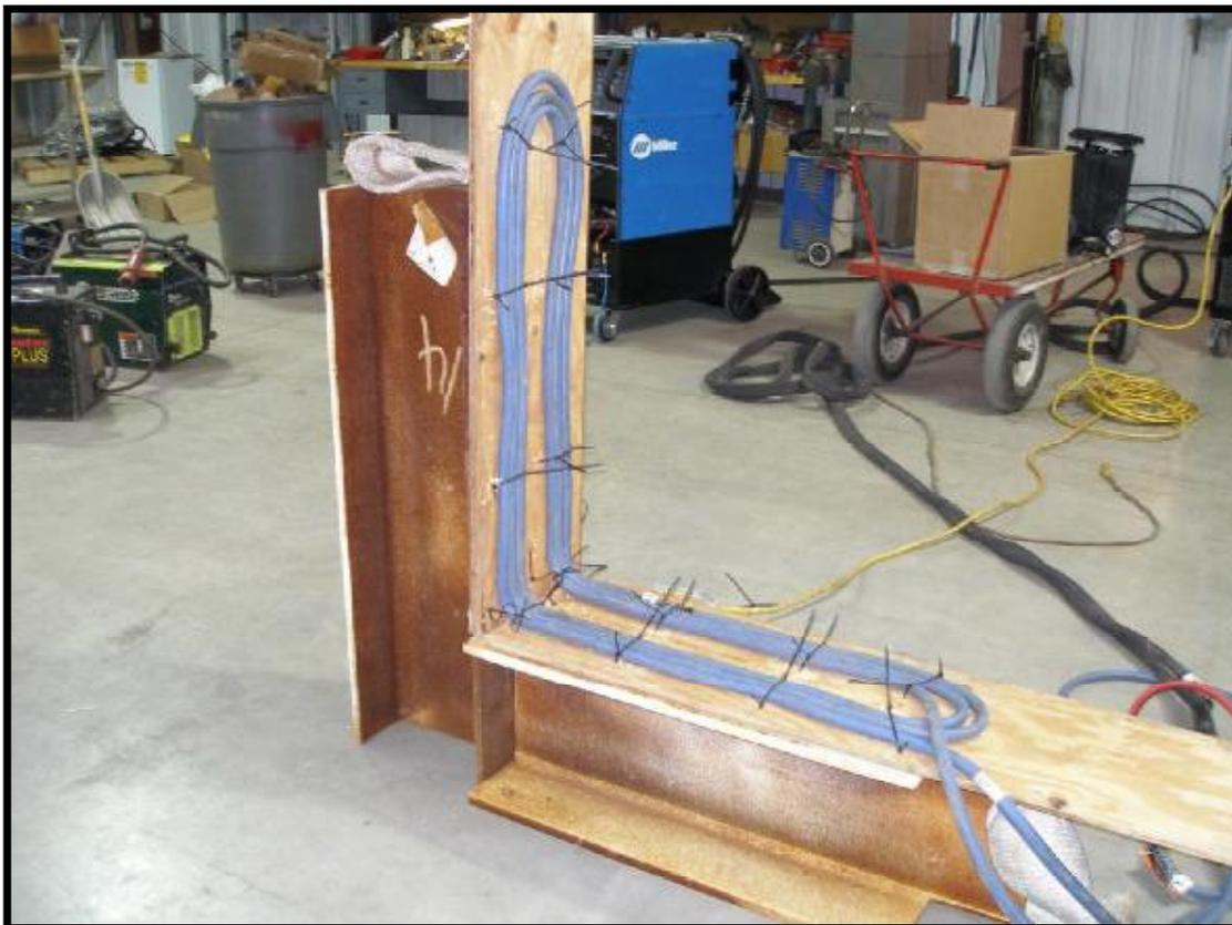
Плоская конф. обмоток может использоваться для нагрева стыков в горизонтальной плоскости или под углом. См. фото нагрева стыка двух несущих тавровых балок, перпендикулярных друг другу. Фанера, часто используется для крепления обмоток для нагрева 204 С и ниже. Обратите внимание на полдюймовую изоляцию.
