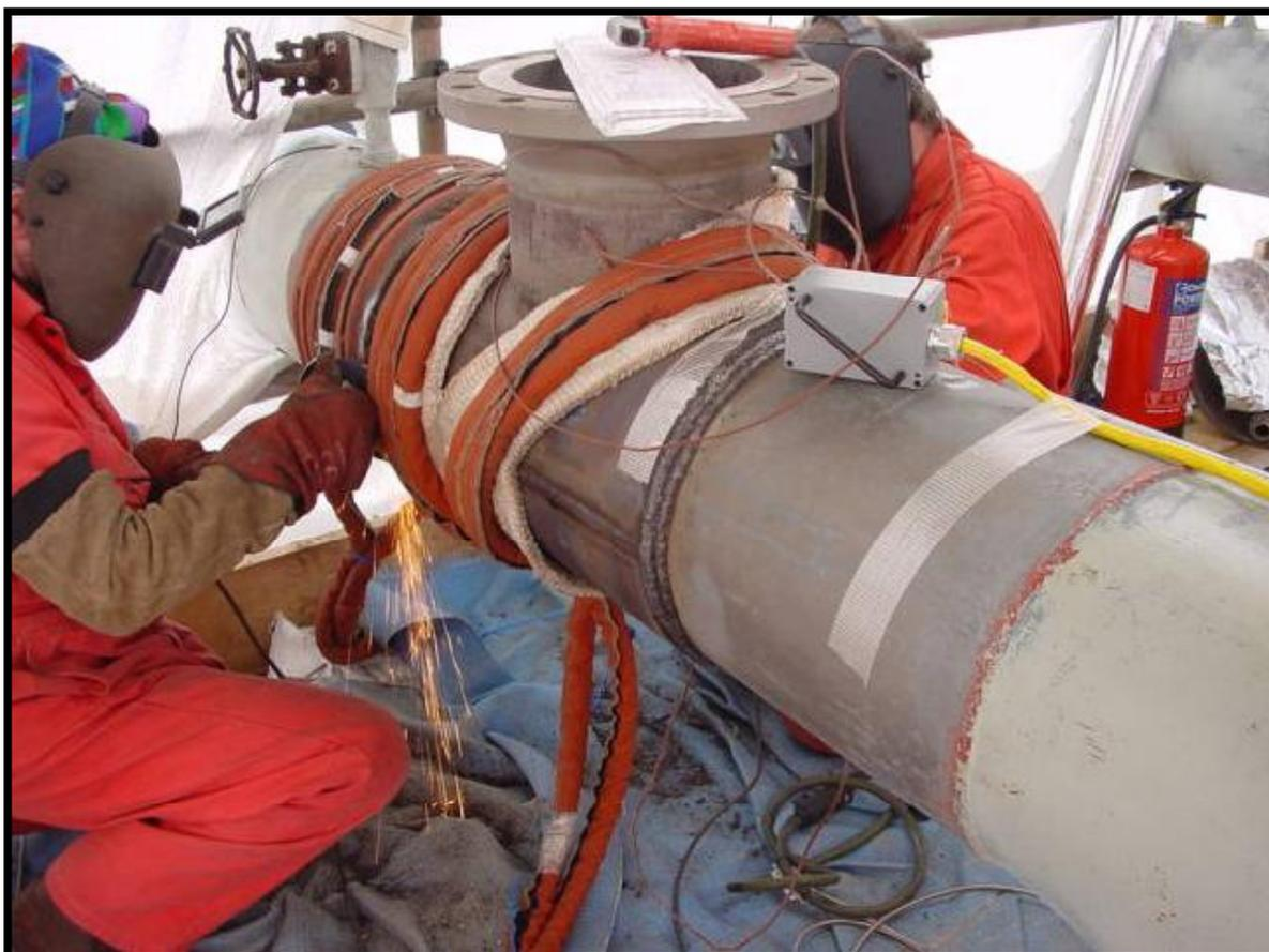
Для соединения с основной трубой необходимо заварить круговые стыки на каждом конце Т-образной, 2-х секционной врезки.
