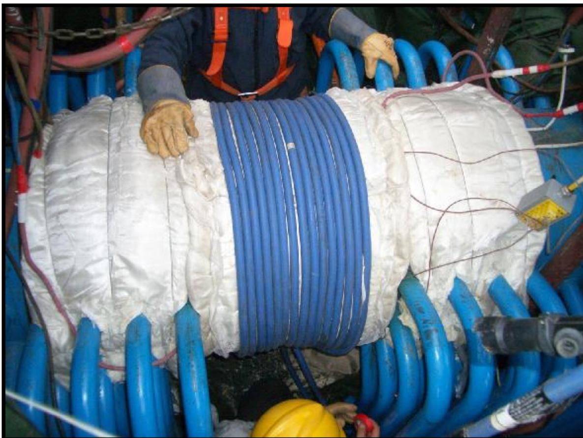
Технические задания по сварке труб и бойлеров (P91, P92) теплоэлектростанций обычно предписывают “выдержку” при  $T$  1400F (760 C). Очень важно минимизировать потери тепла и это возможно, за счет дополнительной наружной изоляции индукторов для сохранения температуры.
