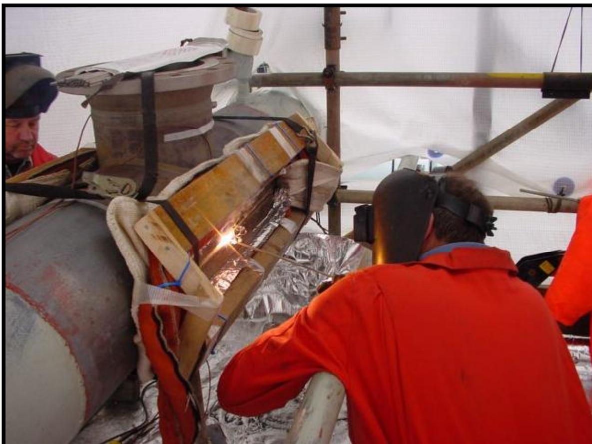
Осуществляется сварка/врезка “тройника” (2-х секц. Т) для промышленного трубопровода перерабатывающего завода. Локализованный нагрев легко осуществляется индукционным нагревом для поддержания температуры при наложении сварочных швов. Деревянная форма использована для позиционирования обмотки для нагрева стыка двух секций.
