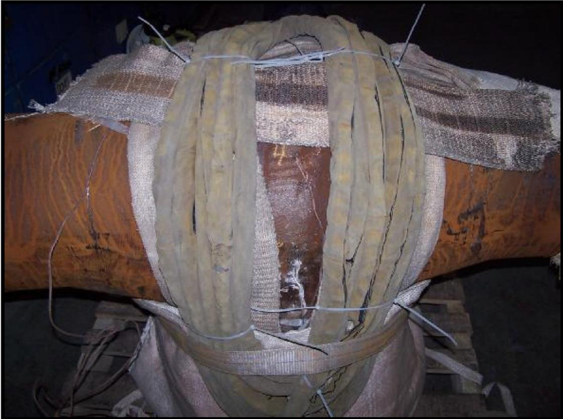
Фотография нагрева корпуса заглушки для ремонта, демонстрирует возможности индукционных кабелей менять конфигурацию площади нагрева, принимая геометрические формы нагреваемых конструкций.
