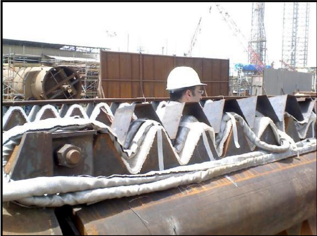
В данном случае “зубцы” подъемника требуют нагрева перед сваркой к несущей трубе. Гибкие индуктора индукционного нагрева с жидкостным охлаждением легко следуют контурам различных геометрий.
