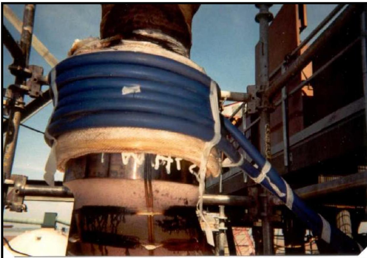
Proheat идеально подходит для сварки стыков труб различной конфигурации при строительстве теплоэлектростанций. Термопары привариваются к трубе согласно задания обработки и закрываются многоразовыми изолирующими пледами с силиконовой нитью. Витки индуктора наматываются поверх изолирующего материала и свободно удерживаются на вертикальной трубе.
