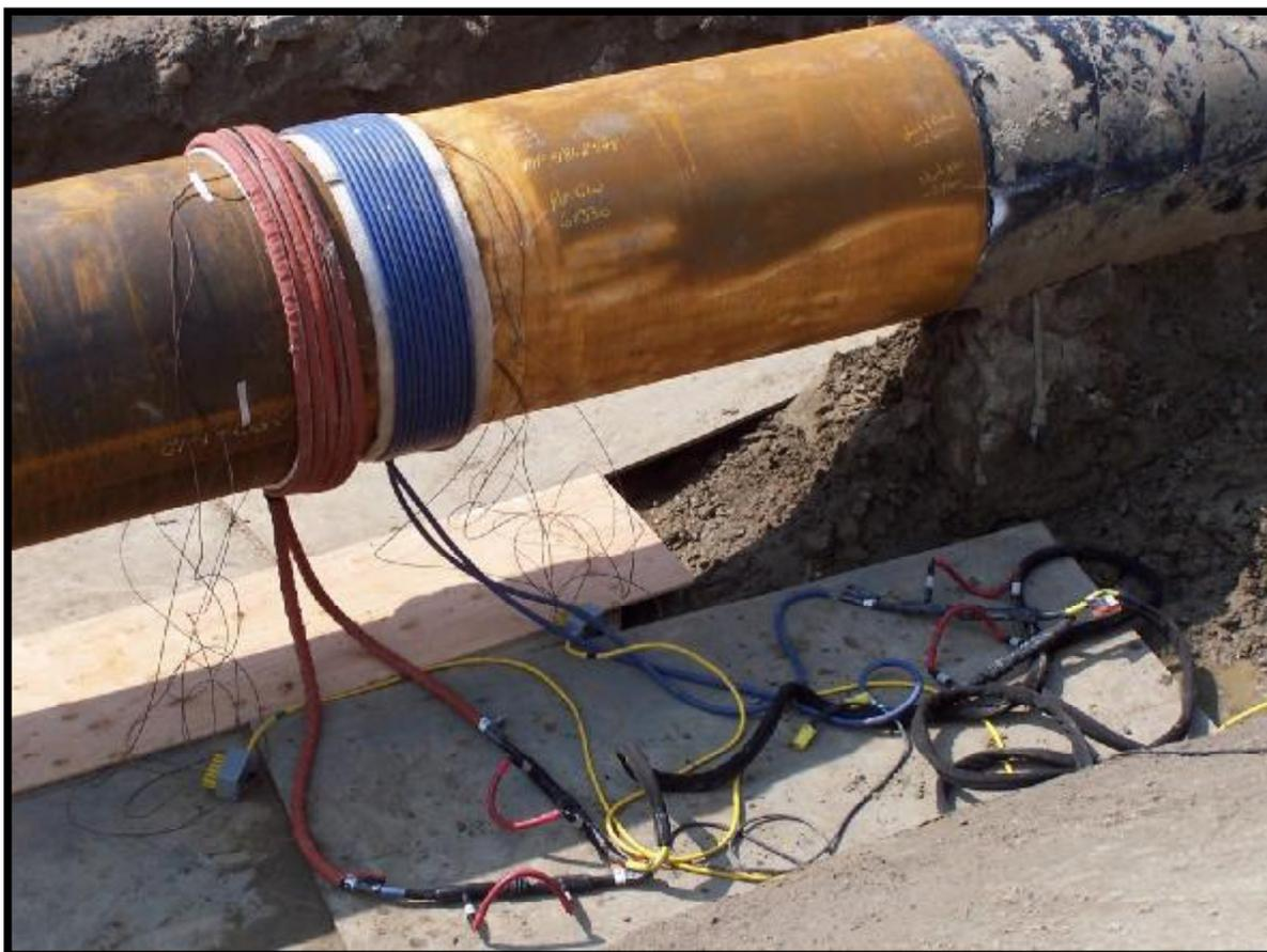
“Рукава” повышения прочности часто привариваются к секциям старых нефтепроводов. В данном случае два аппарата использовались для независимого нагрева и контроля температуры стыков нефтепровода и “рукава” перед сваркой.
