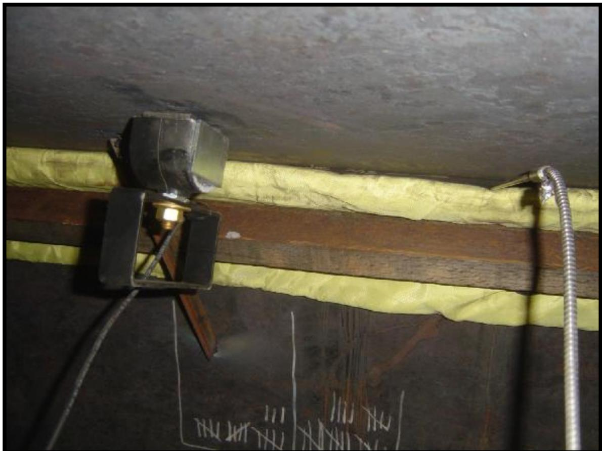
Нагрев необходим перед сваркой толстостенных листов в структурном строительстве. В данном случае листы стали нагревались с обратной стороныстыка. Длинная деревянная доска используется для плотного прижатия индукционного одеяла к стали. Контрольные термопары всегда располагаются на стороне индуктора см. Фото. (Температурный датчик слева)
