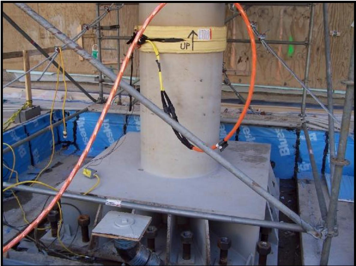
Прочные толстостенные трубы иногда используются в качестве несущих опор. Эти примеры можно встретить на “плавучих” платформах, конструкциях зданий, крыш, последнее показано на фото. Во многих Тех. заданиях для строительства опор требуется нагрев, во избежание рисков трещин на швах. Обратите внимание, что одеяло зафиксировано на вертикальной трубе.
