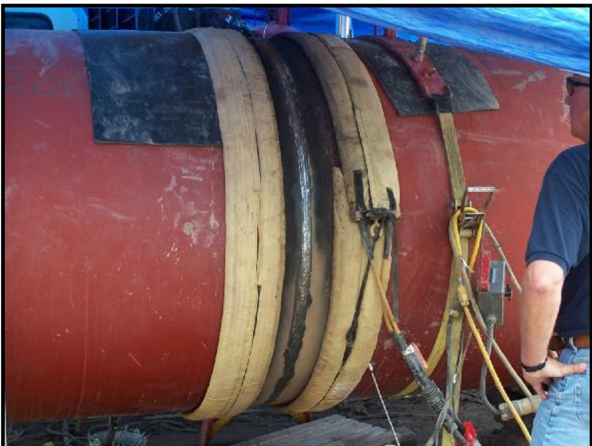
При сварке стыков трубопроводов большого диаметра требуется поддержание мин. температуры для последующего шва. В этом случае, термопары расположены в нижней части под индукционным одеялом и Proheat запрограммирован на температуру выше требуемого минимума, для полной уверенности что в зоне сварки температура достигает необходимых параметров.
