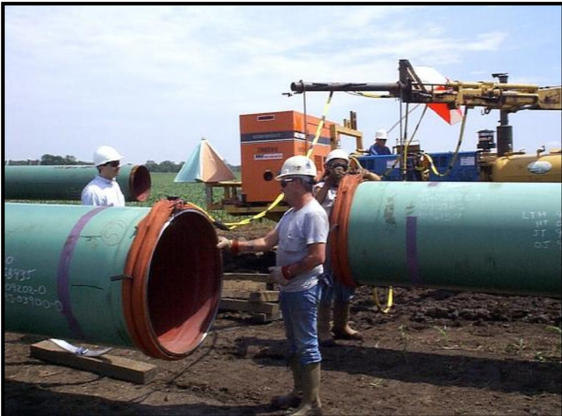
Проекты строительства трубопроводов требуют Предварительного нагрева перед сваркой. Стыки этих 36-ти дюймовых труб были нагреты стандартными инд. одеялами. Необходимость защиты одеял привело к использованию чехлов Kevlar. Рабочие определяют Т град.С на стыке и дают “добро” оператору трактора. Он отключает Proheat с помощью дистанционного выключателя .
