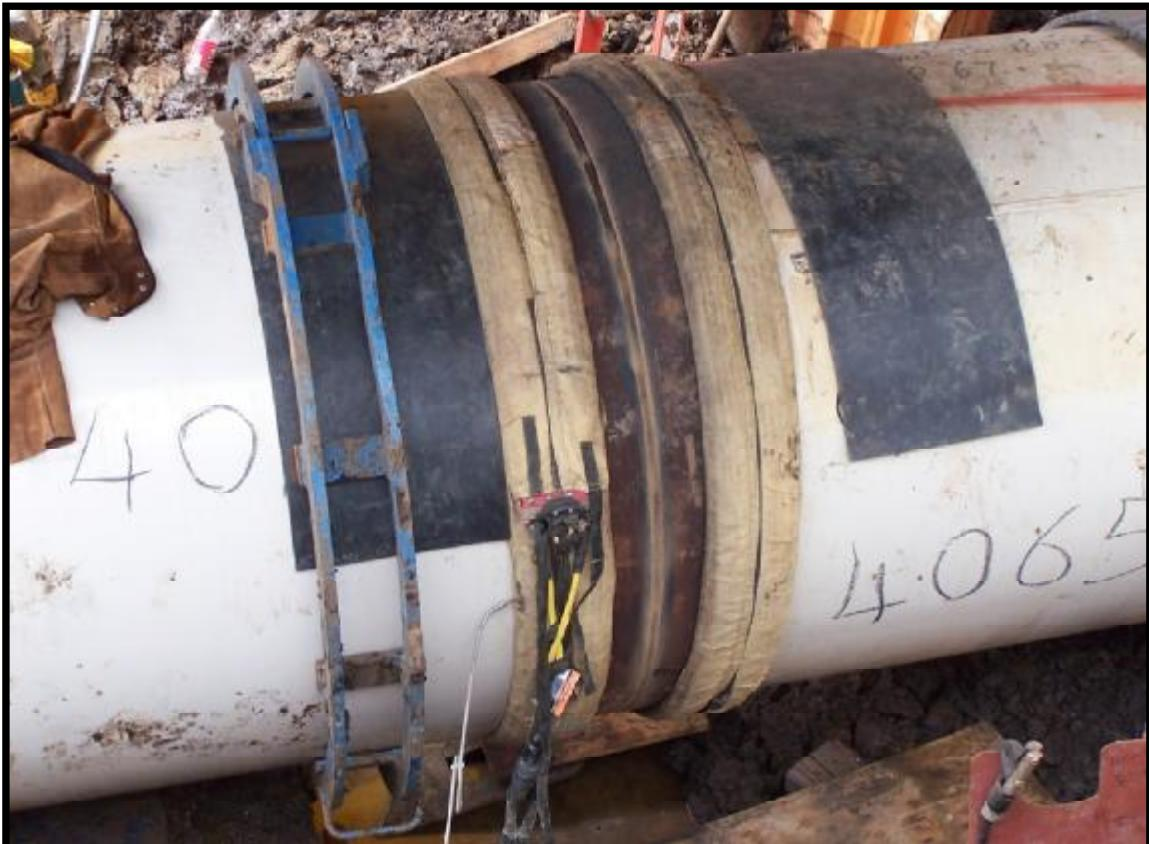
Требование предварительного нагрева характерно для “прихватки” при выравнивании во время строительства новых трубопроводов. Обычно они необходимы при пересечении дороги или реки. Наличие удлинительного кабеля 24 м позволяет проводить нагрев при любой глубине траншеи. Наружная струбцина для выравнивания стыков (слева от индуктора) была расположена на стыке для прихватки и затем отодвинута для заварки шва.
