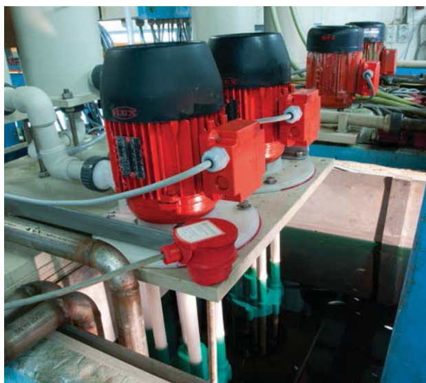
F 716 Циркуляция химикатов в ванне с электролитом
