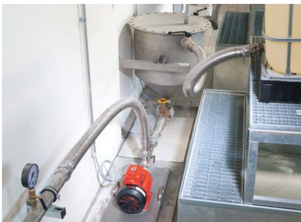
F 550 TR в работе в промышленном секторе - перекачивание вязкого умягчителя
