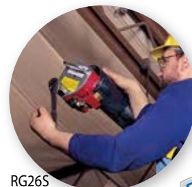
RG26S в работе на стальной трубе
