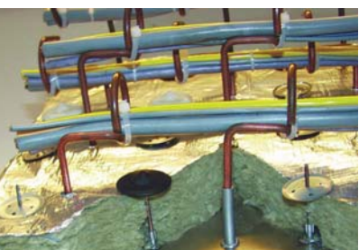
Крепление теплоизоляции и кабелей
