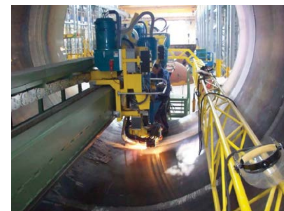
▲ Специализированная установка для наплавки ленточным электродом.
